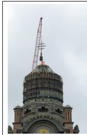
Poza 6. Montajul structurii metalice pentru cupola
